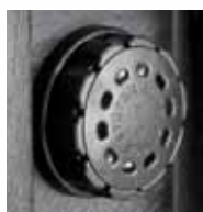
Valvola di pressurizzazione automatica
